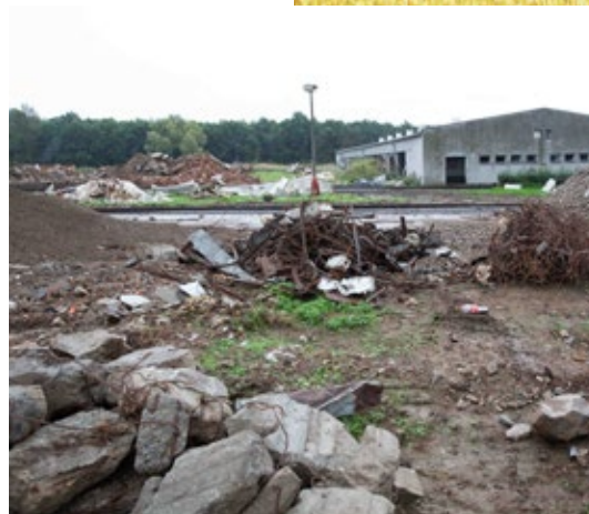
demolice vepřína, 2022 (zdroj: Muzeum romské kultury)
